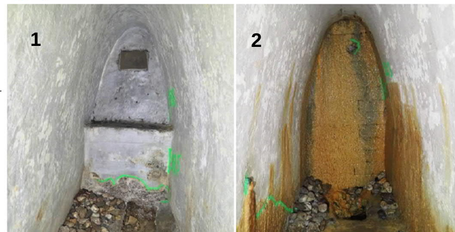
Obrázek 4. Čelba levé a pravé štoly
