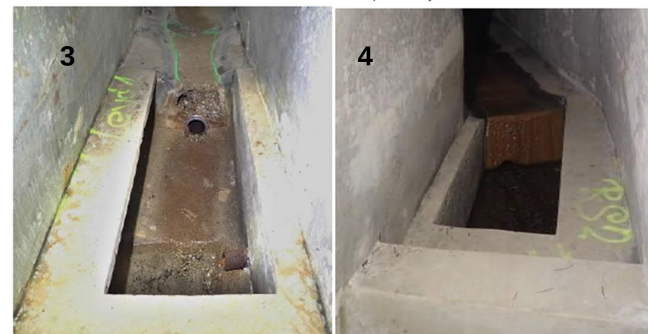
Obrázek 5. Odtokové jímky levé a pravé štolý
